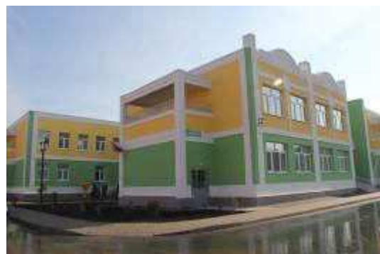
Фото № 5. Фасад ДООУ № 97.
